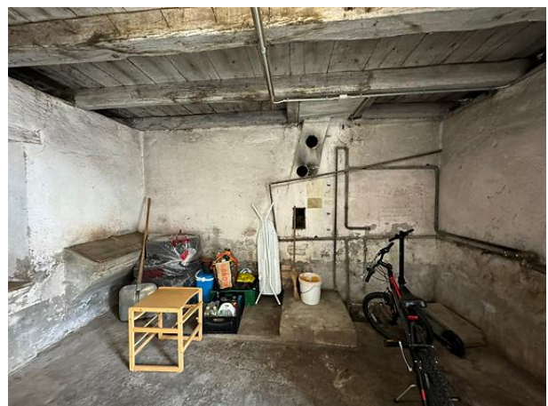
Giebelwand Nordwest, Foto Schaub 2023
