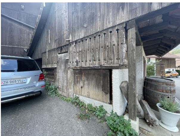
Schweineställe und Latrine, Foto Daniel Schulz 2023
